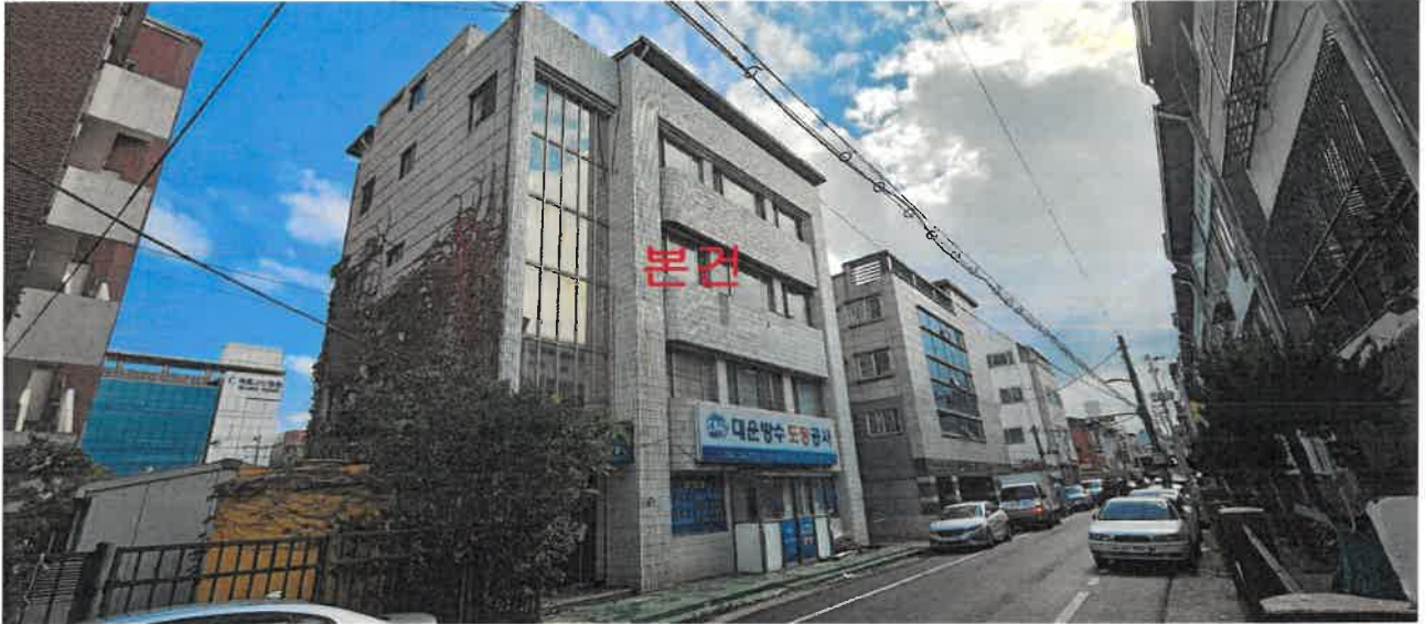
전경 - 본건 북서측에서 촬영
