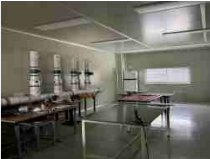
기호(가) 1층 내부 전경
