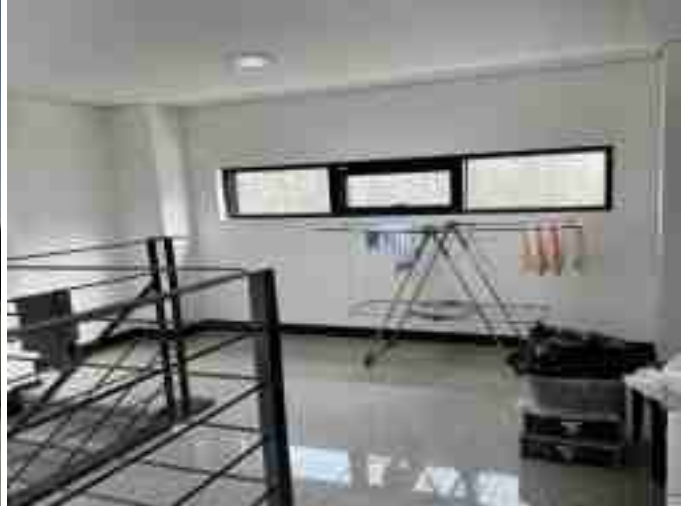
기호(가) 옥탑1층 내부 전경
