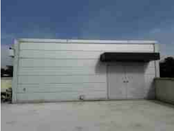
기호(가) 옥탑1층 전경
