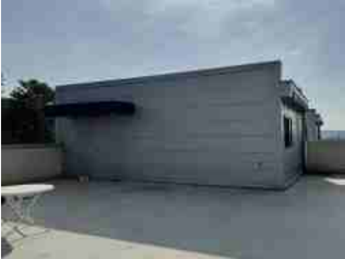
기호(나) 옥탑1층 전경
