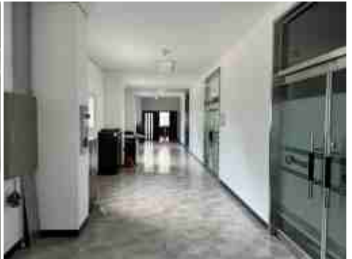
기호(가) 2층 내부 전경
