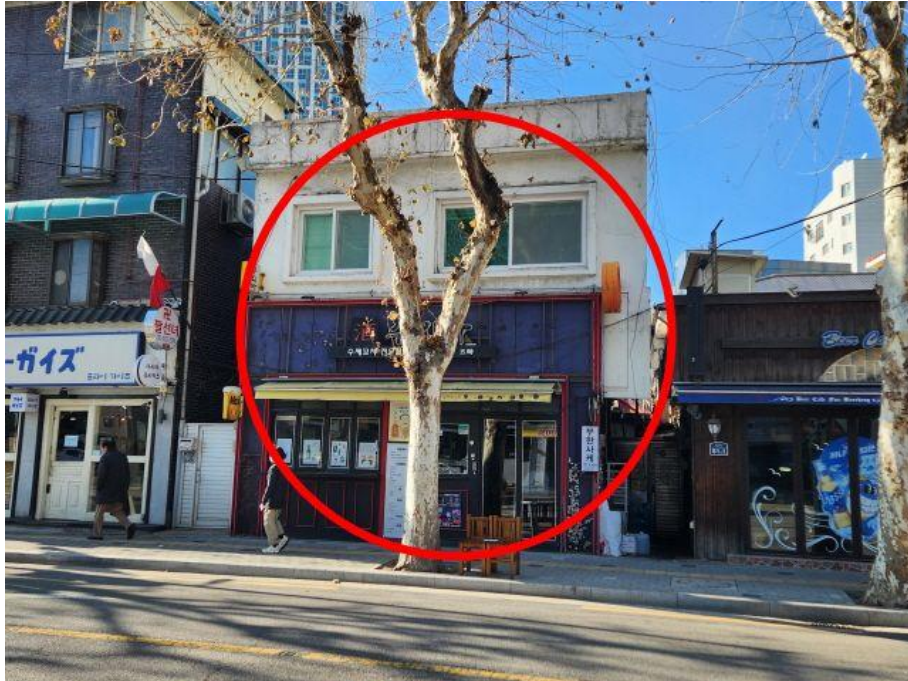
본건 전경 및 일련번호(나) 전경
