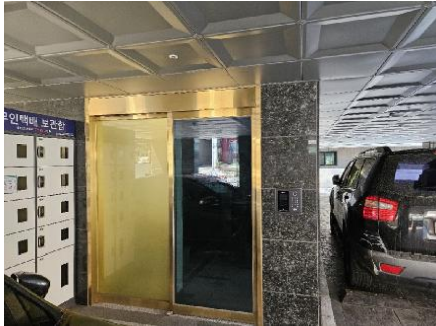
[본건 1층 출입구]
