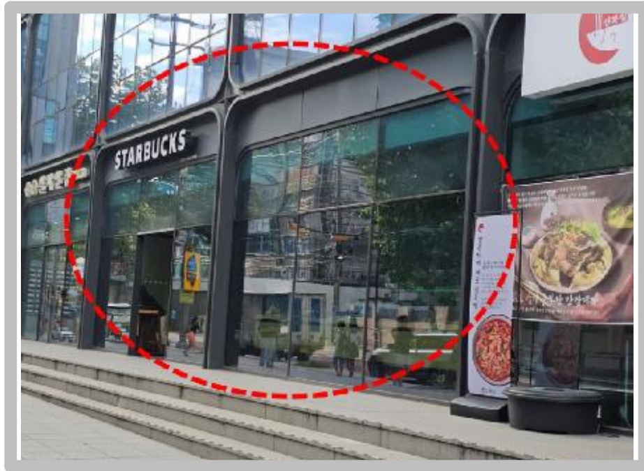
【 대상물건 기호 (다) 출입문 】
