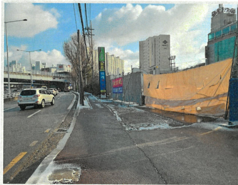
【본건 전면 전경 및 도로】
